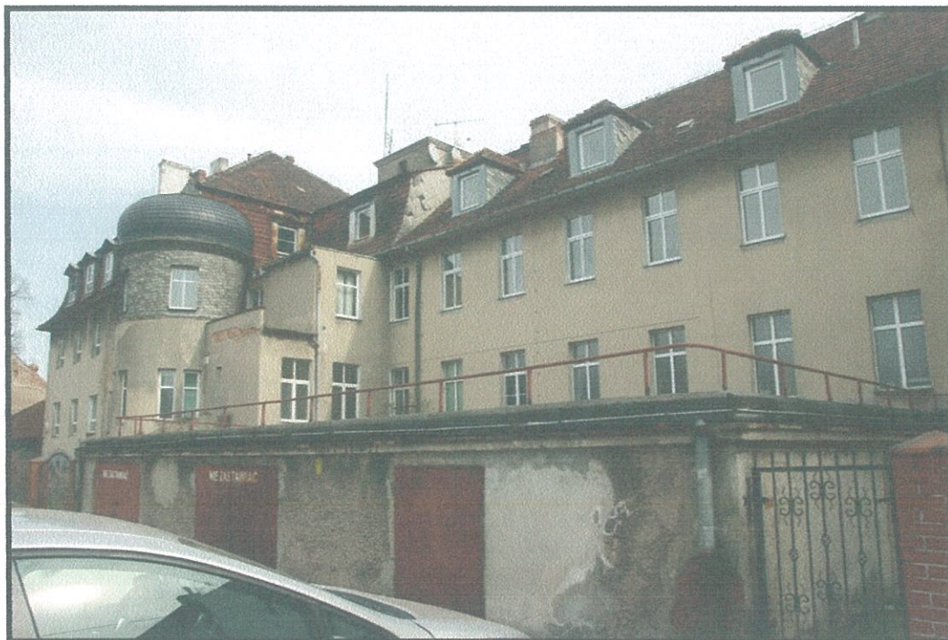
Fotografia 6: Widok na zachodnią elewację budynku.
