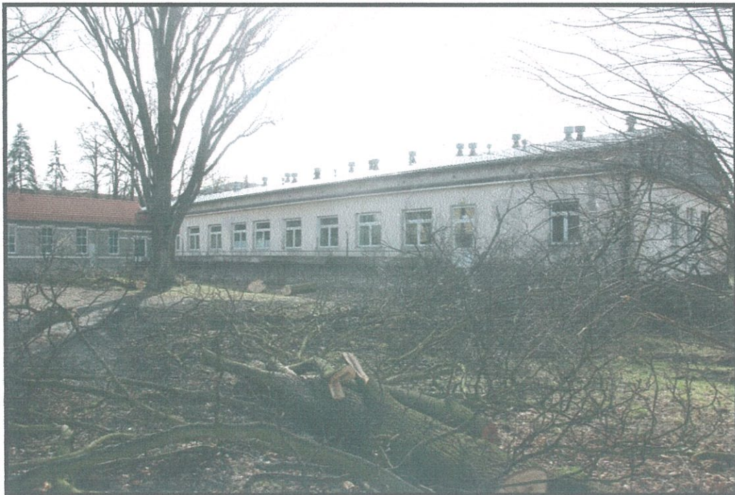
Fotografia 6: Widok na wschodnią elewację budynku.
