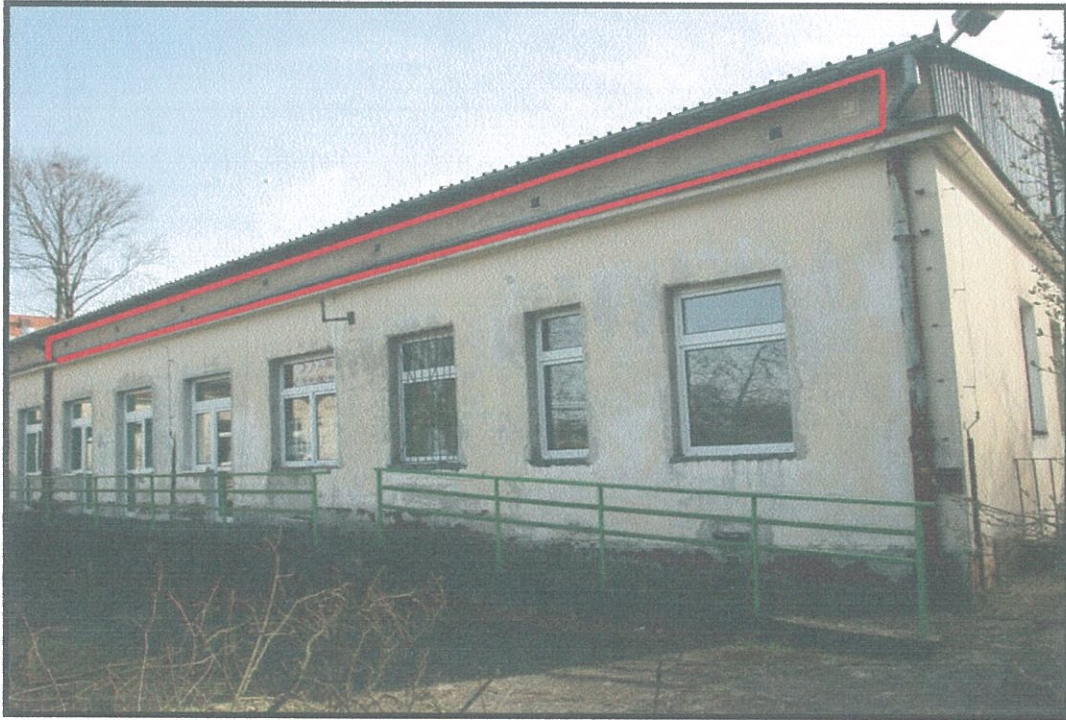
Fotografia 3: Widok na północną elewację budynku z zaznaczoną strefą w której należy dokonać montażu budek lęgowych.
