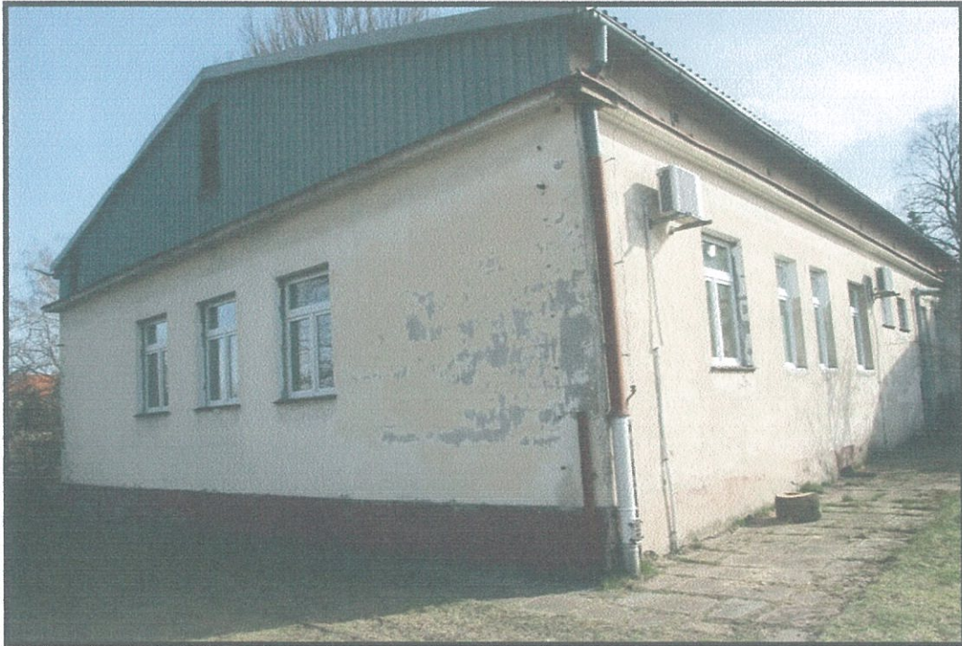
Fotografia 5: Widok na północną i zachodnią elewację inwentaryzowanego budynku.
