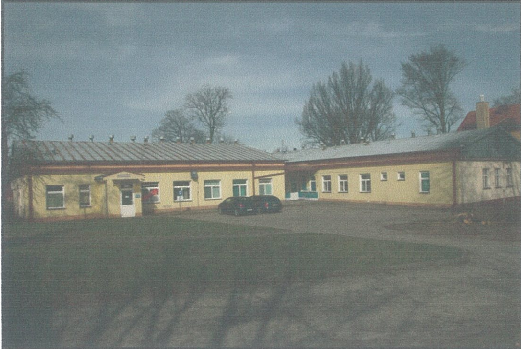
Fotografia 1: Widok na północną oraz zachodnią elewację inwentaryzowanych budynków.
